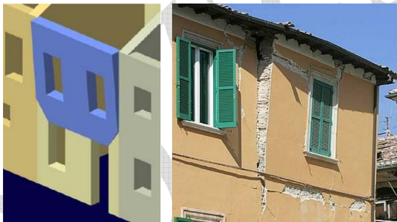
Figura 5: Schema ed esempio di ribaltamento semplice di parete posta all'ultimo piano
