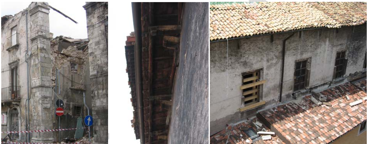
Figura 7: Catene lignee inefficaci (sinistra); catene lignee entrate in funzione durante il sisma, bloccando il ribaltamento ed attivando un meccanismo di flessione verticale (vedi §3.4.3; centro e destra)
