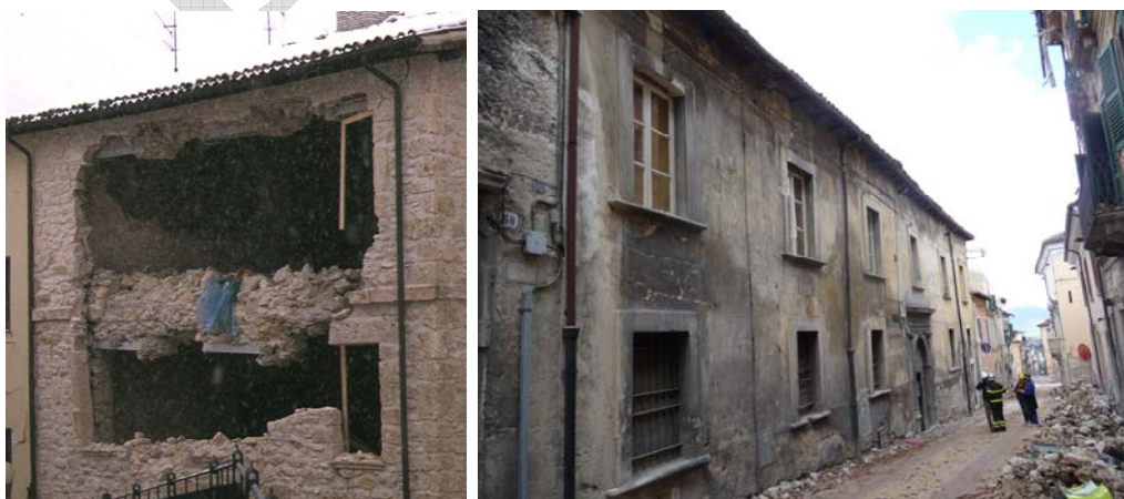
Figura 11: Flessione verticale per martellamento solaio (sinistra) e per spinta delle volte (destra)
