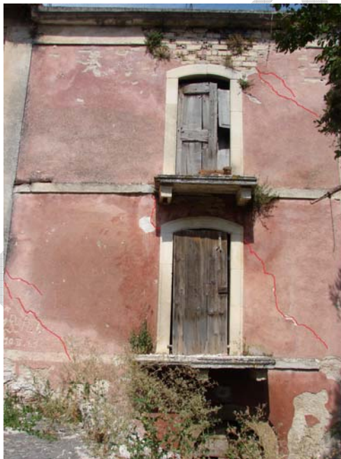
Figura 3: Esempi di lesioni concentrate in prevalenza nei maschi (sinistra) o nelle fasce (destra)
