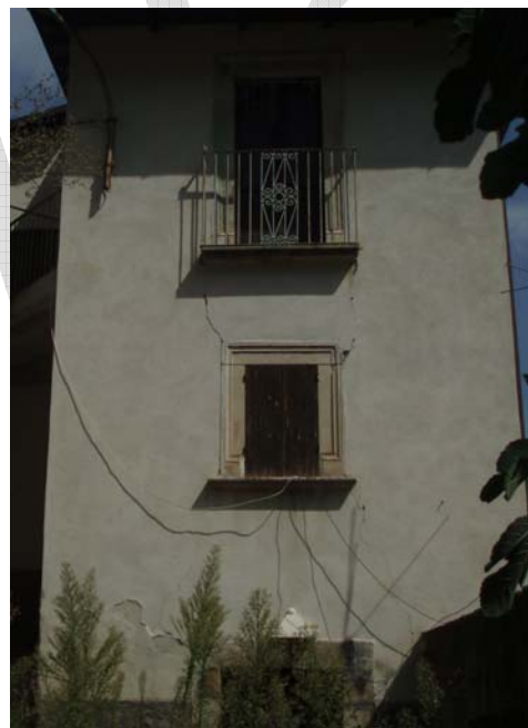
Figura 3: Esempi di lesioni concentrate in prevalenza nei maschi (sinistra) o nelle fasce (destra)
