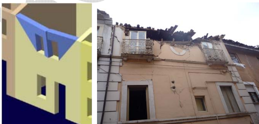
Figura 13: Schema ed esempio di flessione orizzontale
