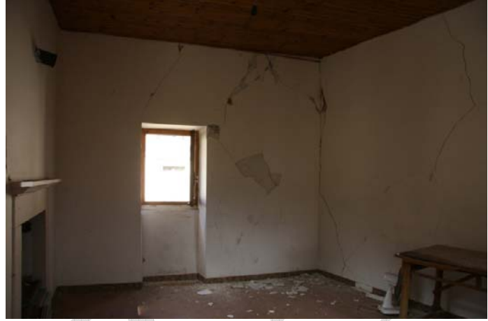
Figura 2: Esempi di lesioni inclinate generiche nel piano della parete in pareti esterne (sinistra) e interne (destra)
