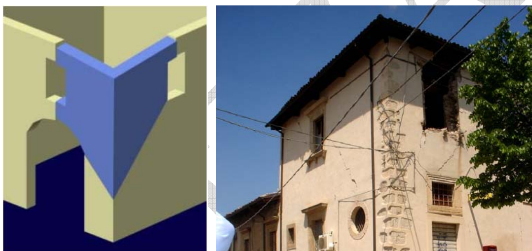
Figura 9: Schema ed esempio di ribaltamento del cantonale
