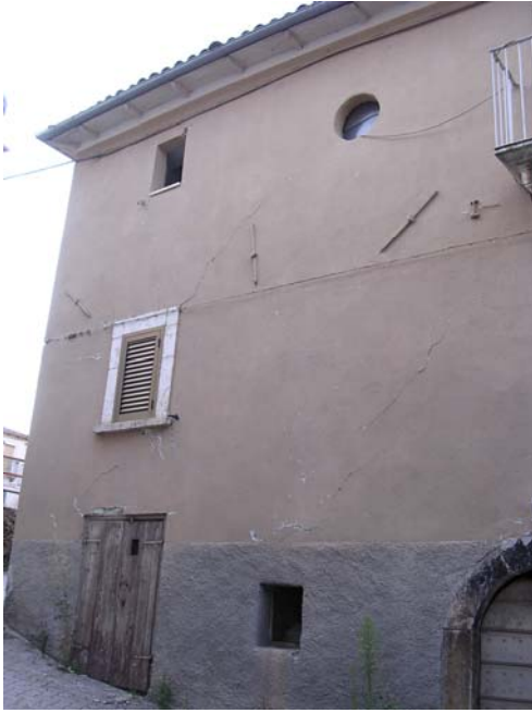
Figura 2: Esempi di lesioni inclinate generiche nel piano della parete in pareti esterne (sinistra) e interne (destra)
