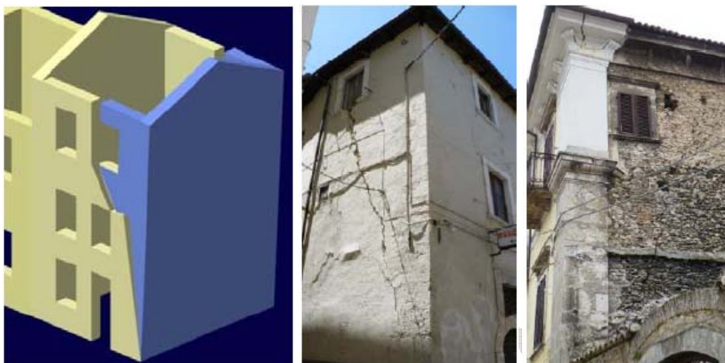
Figura 8: Schema ed esempi di ribaltamento composto
